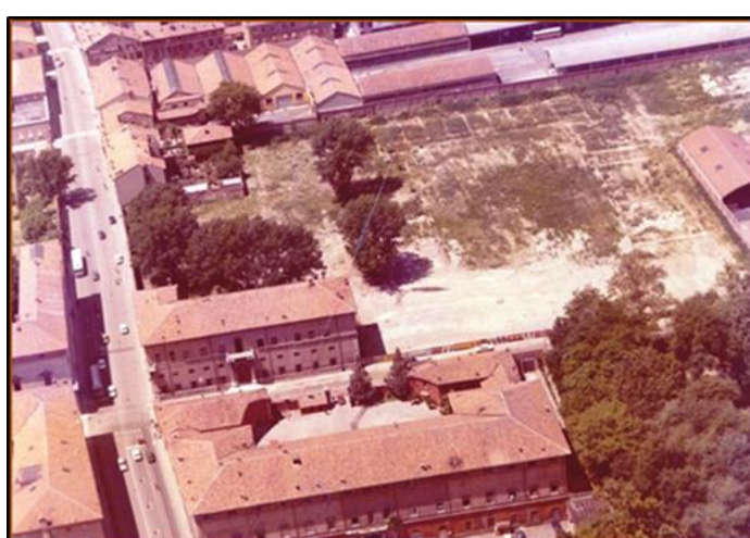
Il quadrivio rossettiano dopo le demolizioni di tutti gli edifici dell'ex Caserma Gorizia
