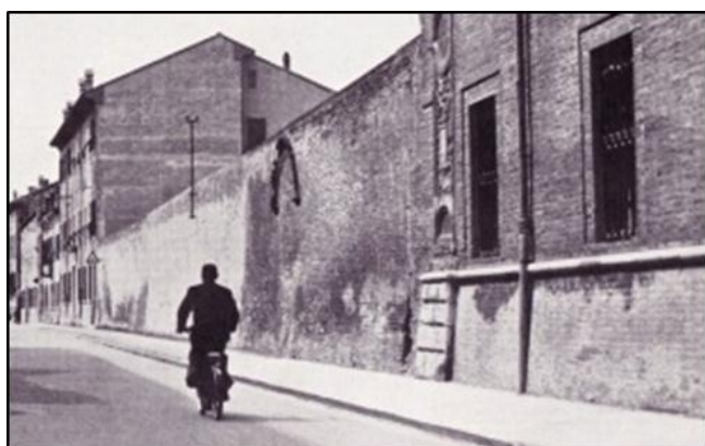
L'ala sud di Palazzo Da Castello – Prosperi – Sacrati, con il portale tamponato, anni '50
