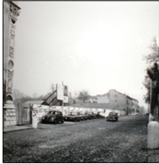
Lo squarcio lasciato dalla demolizione su corso Ercole I d'Este
